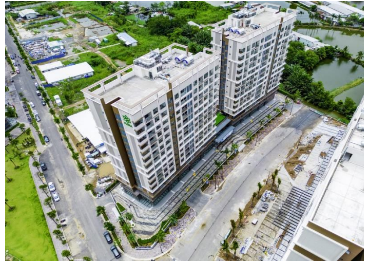
Hình 4: Tòa MP9-10 đã bàn giao từ tháng 6
