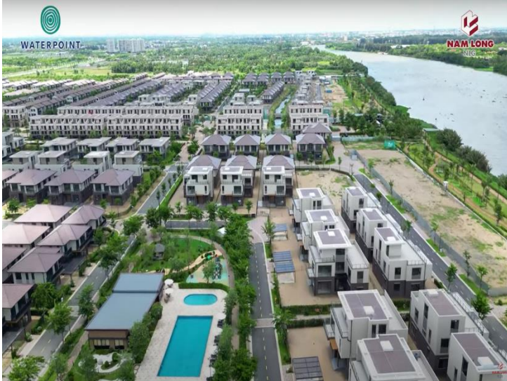
Hình 3: Các phân khu The Aqua đã gần hoàn thiện
